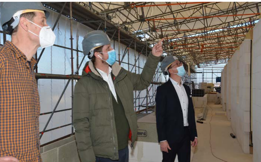
Auf der Baustelle
